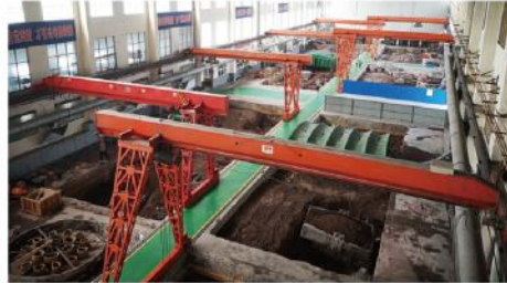
地坑造型 Pit Molding
